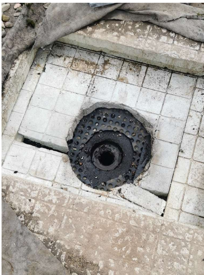
Fotografia nr2 -widok na pluvie odwodnienia dachu.
